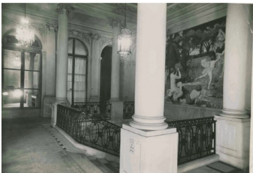
Premier étage de la galerie Maratier, avec au fond un tableau de K. X. Roussel. (Coll. privée)
